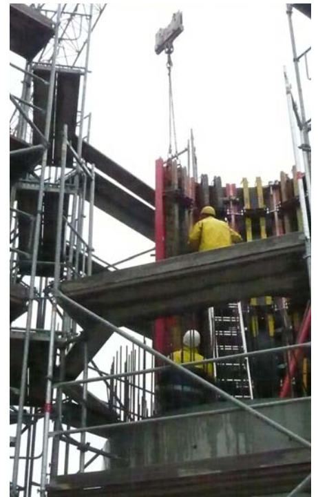
Lüfterstation am Ostportal
