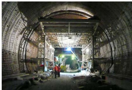
Blick in den Tunnel mit Bewehrungs- und Schalwagen
